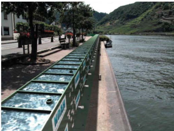
Slika 1. Borba vodom protiv poplave: Noah sistem korita šteti vremenu, materijalu i radnoj snazi
