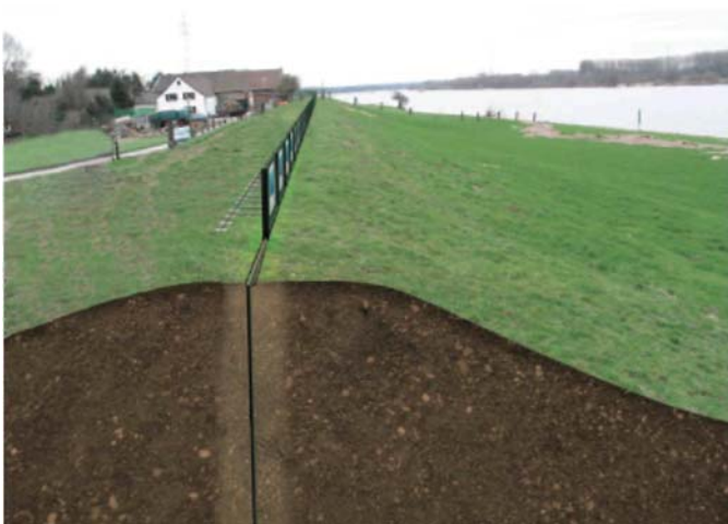
Slika 2. Ploče za utvrđenje nasipa od polietilena koji ne zagađuje životnu sredinu mogu se bez štetnih posledica ugraditi u nasip. Pomoću mobilnih ploča za povećanje visine nasip se po potrebi može brzo i pouzdano povisiti.
